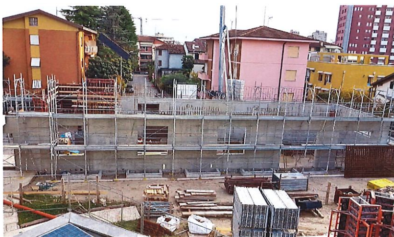
il cantiere a Novembre 2022
